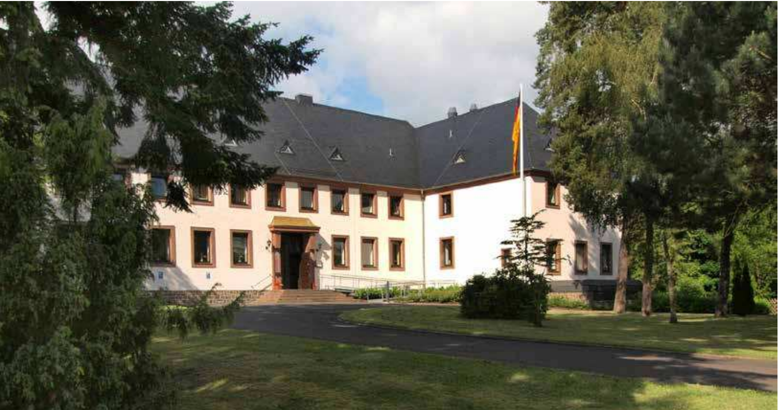
Der Eingangsbereich des Casinos am Barbaring 75
