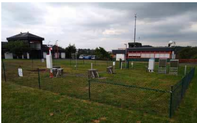
Dienstgebäude und meteorologisches Messfeld
